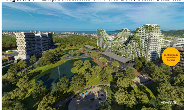
Figura 54 – Empreendimento em Porto Belo, Santa Catarina.
